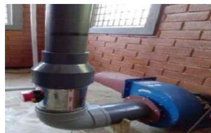
රසායනාගාර වාර්තා හා සාම්පල වායු පුරවන ලද නල ඔස්සේ යැවීමේ පද්ධතිය
