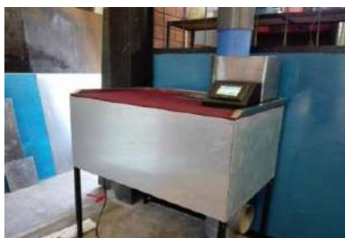
රසායනාගාර වාර්තා හා සාම්පල වායු පුරවන ලද නල ඔස්සේ යැවීමේ පද්ධතිය
